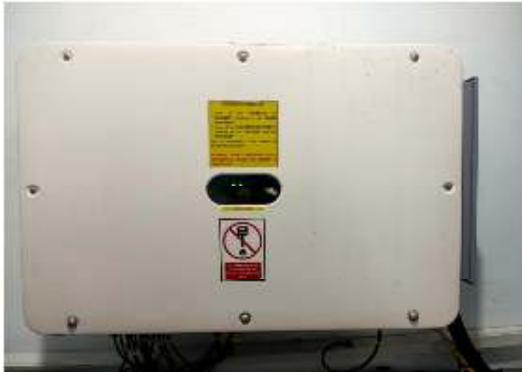
Gambar 3.2 Inverter di power house
