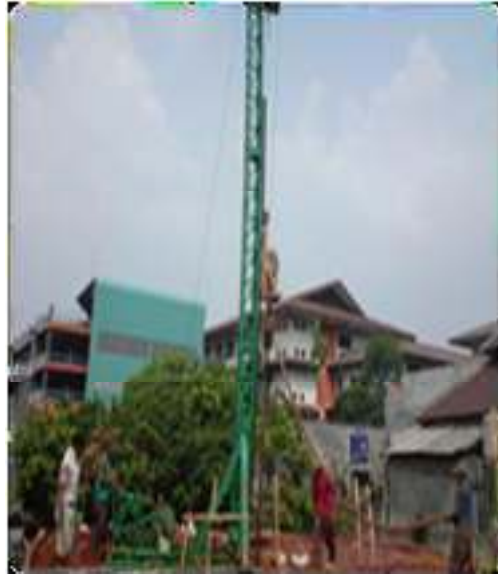
Gambar 2.31 Pembuatan bored pile mini crane
