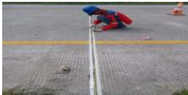
Gambar 2.19 Pemeliharaan Celah Gergajian (Sumber : Larasati, D. Y, 2014)
