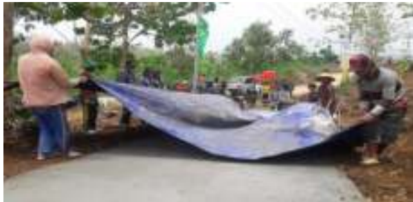
Gambar 2.16 Pemeliharaan Dengan Lembar Goni Atau Terpal (Sumber : Larasati, D. Y, 2014)
