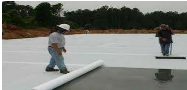
Gambar 2.18 Pemeliharaan Dengan Lembar Polyethylene Putih (Sumber : Larasati, D. Y, 2014)
