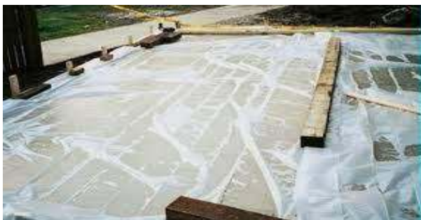
Gambar 2.17 Pemeliharaan dengan Kertas Kedap Air (Sumber : Larasati, D. Y, 2014)
