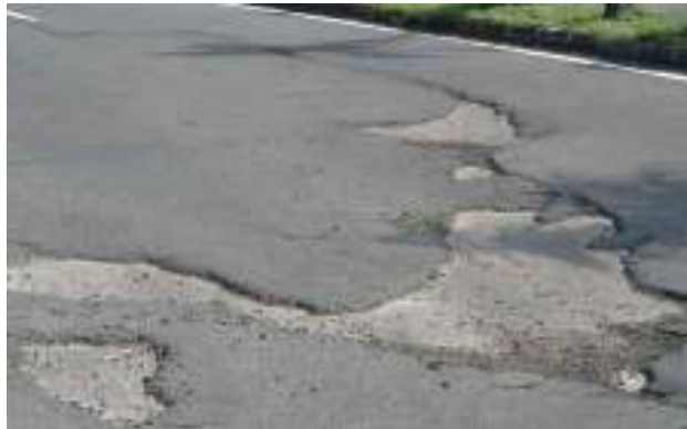
Gambar 2.24 Jalan Abrasi (Sumber : Direktorat Jenderal Bina Marga, 2017)
