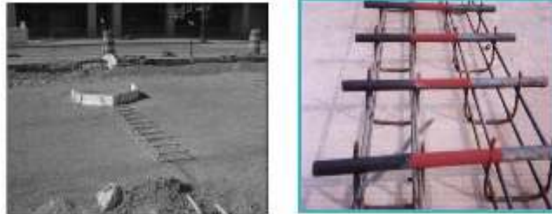
Gambar 2.10 Sambungan Susut Melintang (Sumber : Dinas PUPR, 2017)
