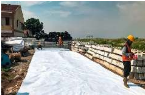
Gambar 2.15 Pemeliharaan Dengan Selaput (Sumber : Larasati, D. Y, 2014)
