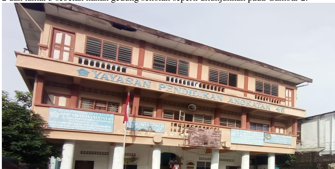
Gambar 2. Kondisi Gedung Sekolah Yayasan Pendidikan Angkatan 45
