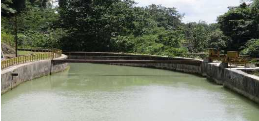
Gambar 3.4. Kolam penenang PLTM Kombih I
