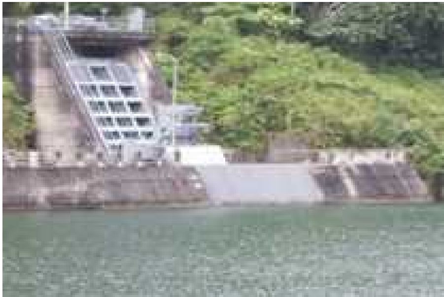
Gambar 3.6. Pintu Pipa Pesat
