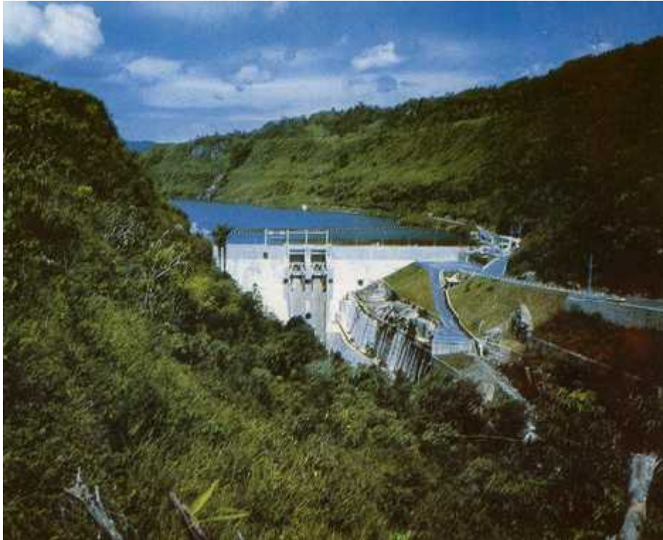
Gambar 3.3. Bendungan Penadah Sigura-gura
