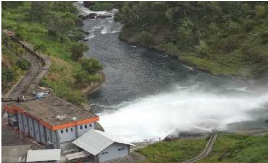
Gambar 2.13 . Saluran Pembuang Bendungan
