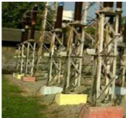
Gambar 2.18. Struktur Penyangga Lightning Arrester
