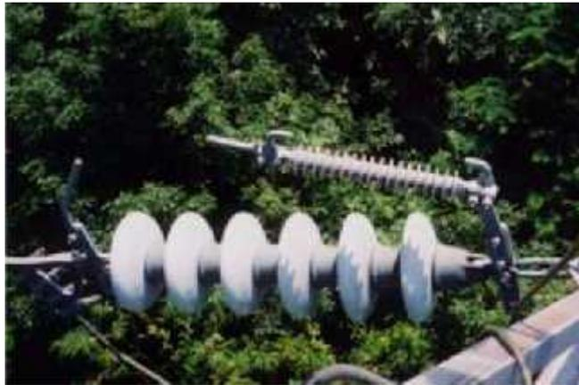
Gambar 2.10.a. LA di Saluran Transmisi dengan gap
