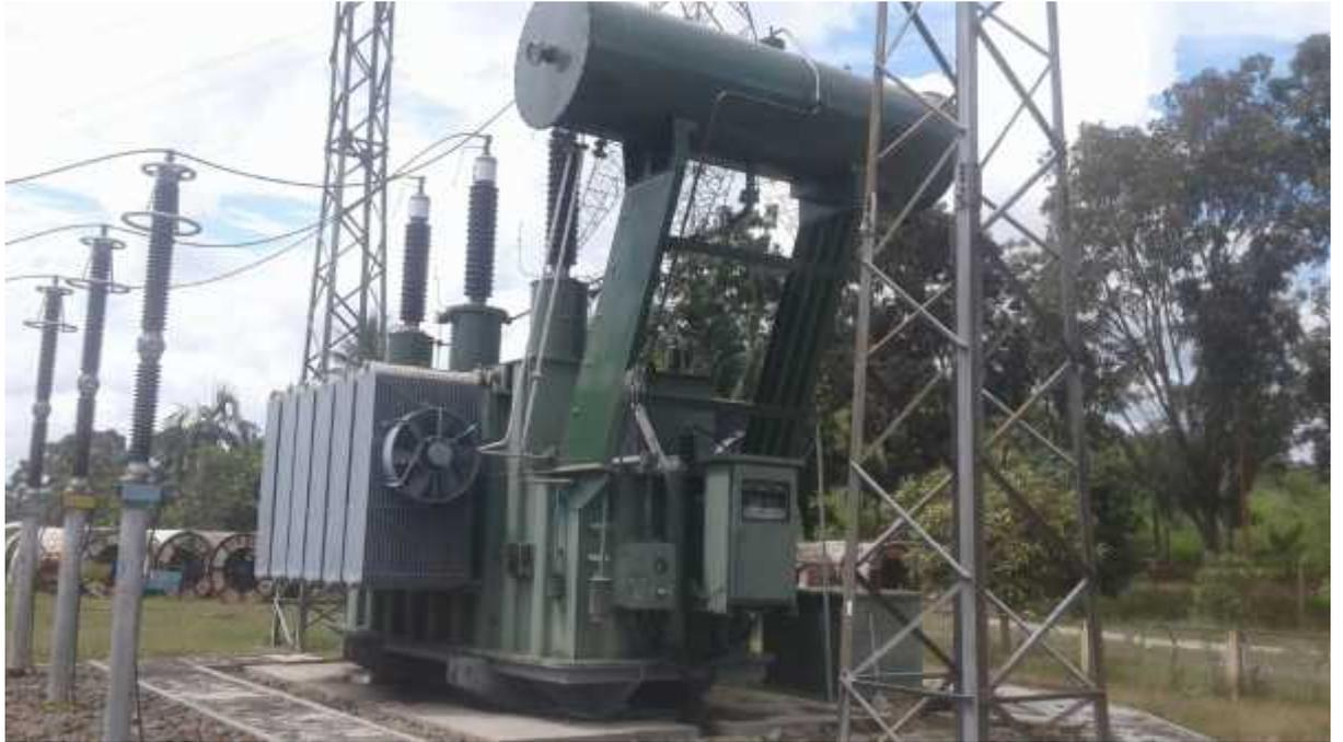
Gambar 3.8. Bentuk fisik trafo II tipe XIAN A94025-3
