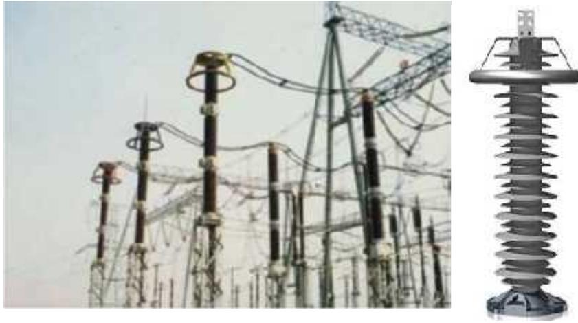
Gambar 2.10 LA di Gardu Induk, dengan housing porselen (kiri) dan housing polymer (kanan)
