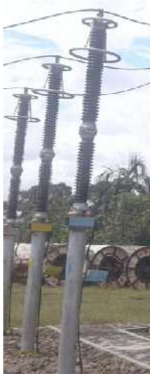
Gambar 3.7. Arrester tipe EMP Tipe 2MB150
