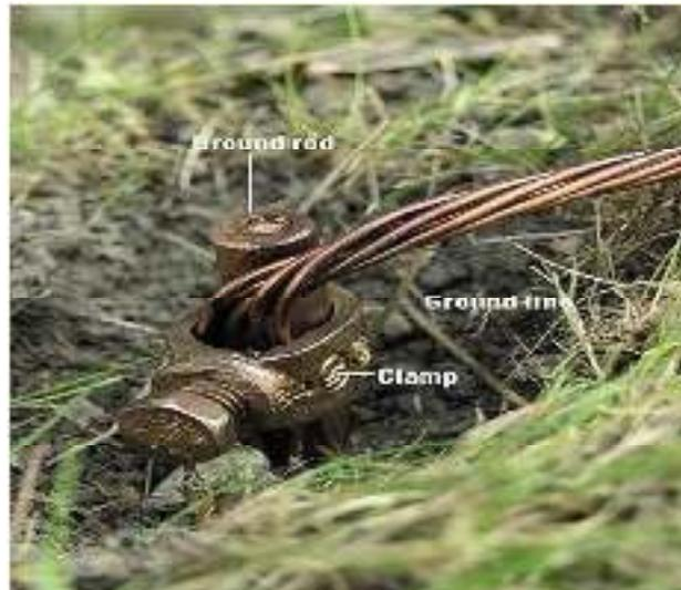
Gambar 2.10. Elektroda *Grounding* (Pembumian)
