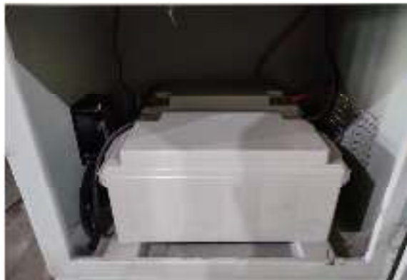
Gambar 3. 3 Baterai JP 65-12G 12V 65Ah
