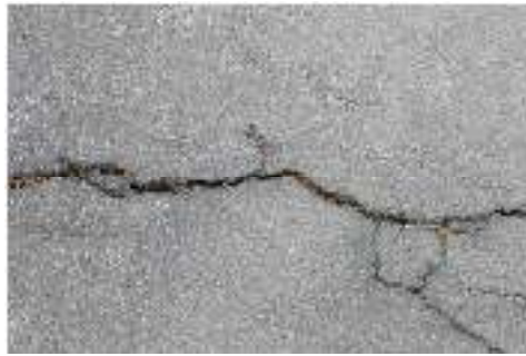
Gambar 2. 10 Retak Alur
