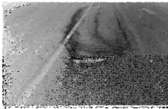
Gambar 2. 9 Retak Slip
