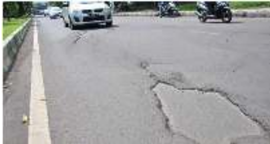
Gambar 2. 17 Pengelupasan Lapisan Permukaan
