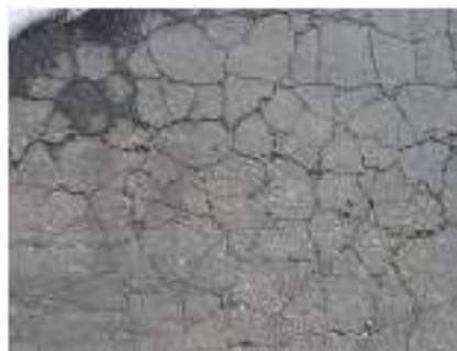
Gambar 2. 8 Retak Susut
