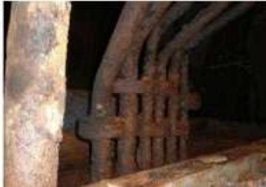
Gambar 2.1 Logam yang mengalami korosi
