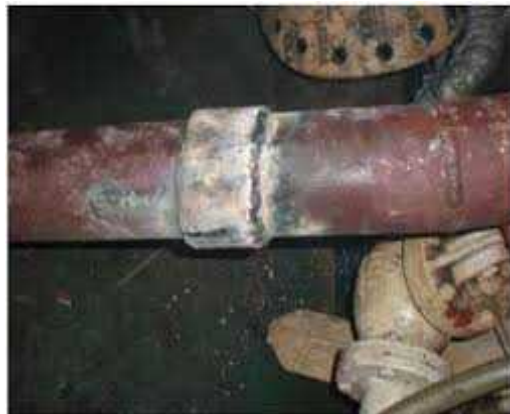
Gambar 2.4 Korosi galvanik (Sumber : Utomo, 2009)
