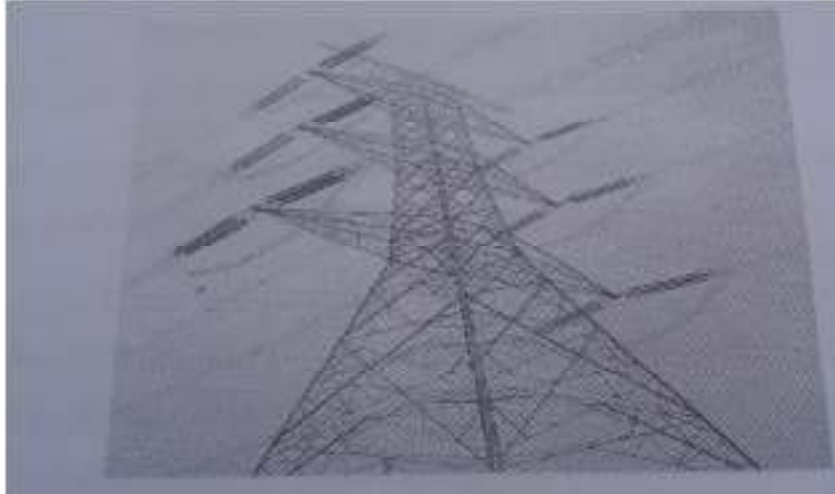
Gambar 2.2 Tiang Transmisi Tenaga Listrik
