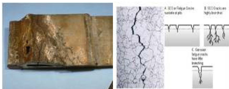
Gambar 2.8: Korosi Retak Tegangan
