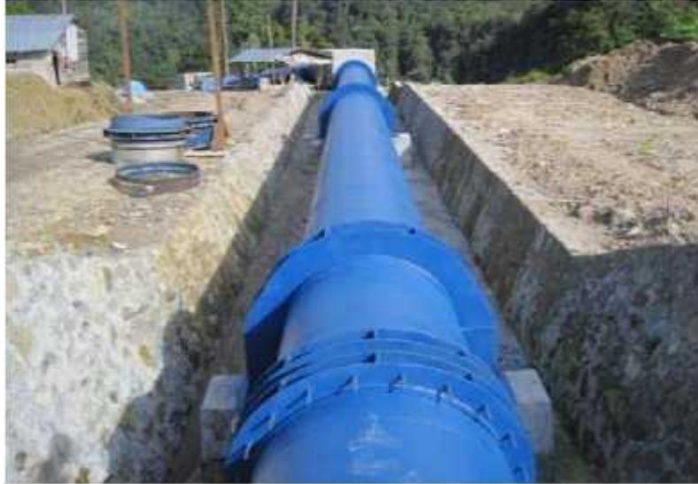
Gambar 2.3.Pipa Pesat(Penstock).
