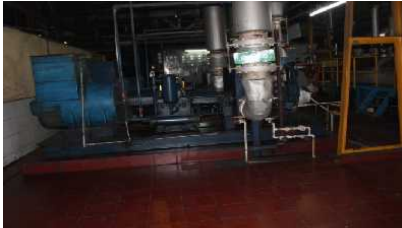
Gambar 3.1 Motor induksi generator listrik yang digerakkan turbin uap protected
