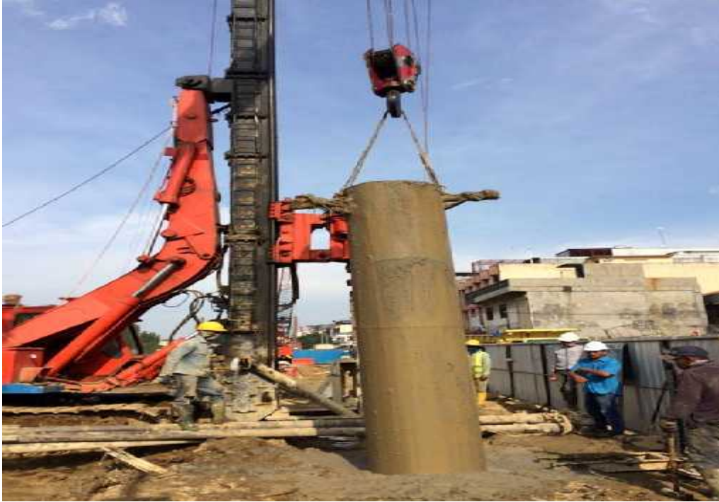
Gambar 1.8 Proses pelaksanaan secant pile .
