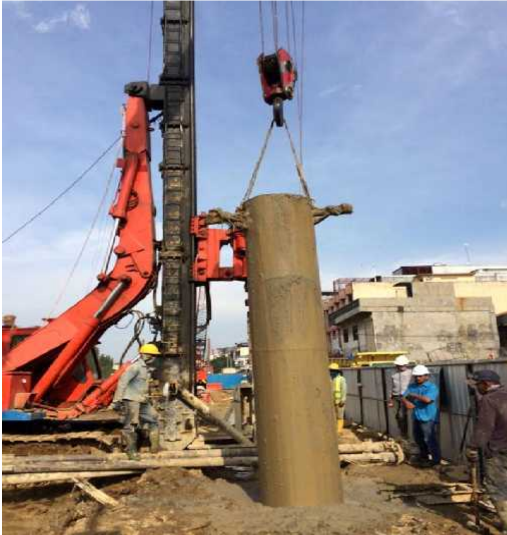
Gambar 3.2 Pengecoran Secant Pile
