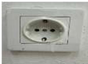
Gambar 2.9 Stop Kontak/Kotak Kontak
