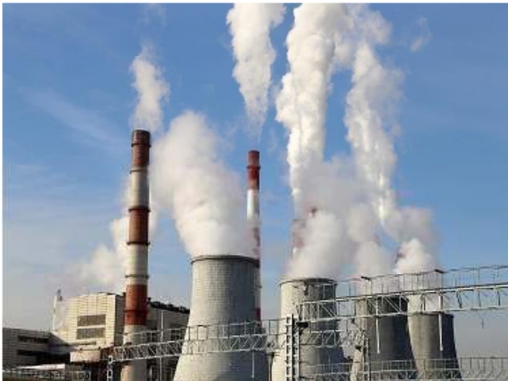
Gambar 2.1 Pembangkit listrik tenaga uap
