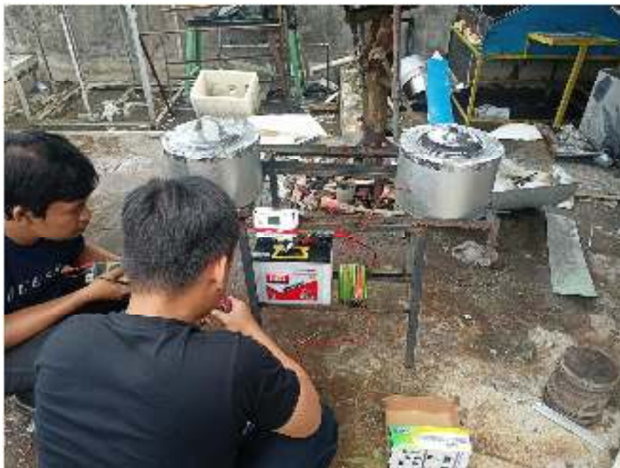
Gambar 3.18 Menyambungkan kabel untuk alat seperti pada panel, SCC, baterai, inverter, Solar Cooker PV
