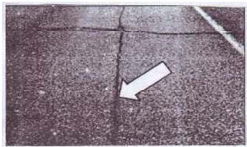
Gambar 2. 8 Retak Memanjang (*Longitudinal Cracks*)
