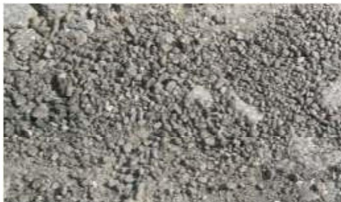
Gambar 2. 16 Kerusakan Pelapukan dan Pelepasan Butir (*Weathering and Raveling*)
