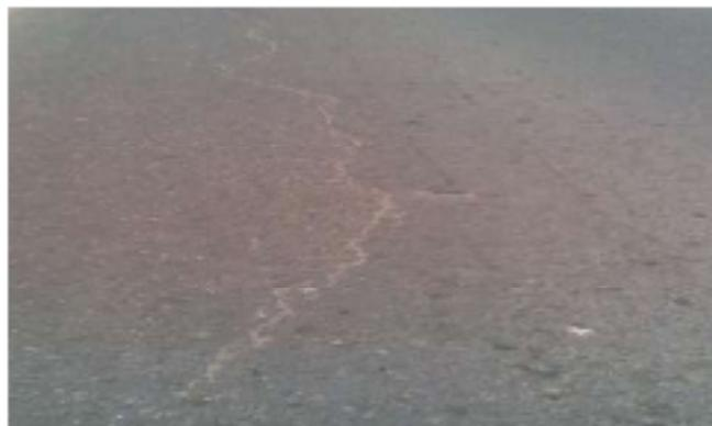
Gambar 2. 11 Retak Berkelok-Kelok (*Meandering Cracks*)
