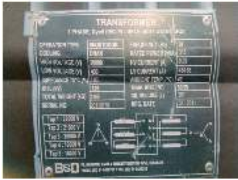
Gambar 3.13 spesifikasi transformator PLTA Pakkat dan transformatornya
