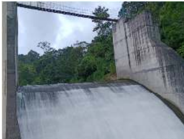
Gambar 3.3 bendungan PLTA Pakkat
