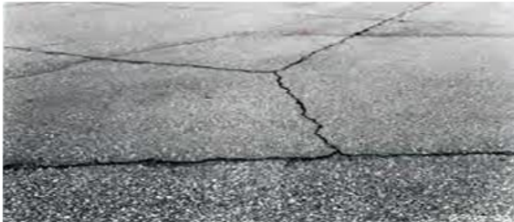
Gambar 2. 8 Retak Memanjang dan Melintang
