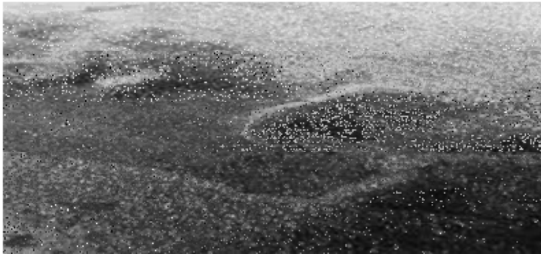
Gambar 2. 12 Tingkat Kerusakan Sungkur (Sumber : Bina Marga no.03/MN/B/1983)
