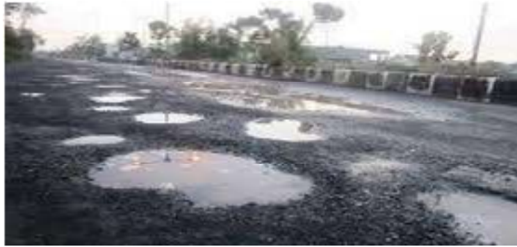
Gambar 2.10 Kerusakan Lubang.
