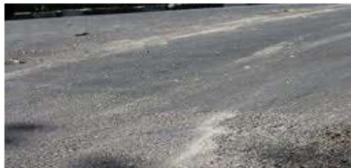
Gambar 2.13 Pelepasan Butir.
