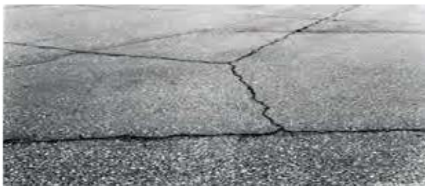
Gambar 2.8 Retak Memanjang dan Melintang
