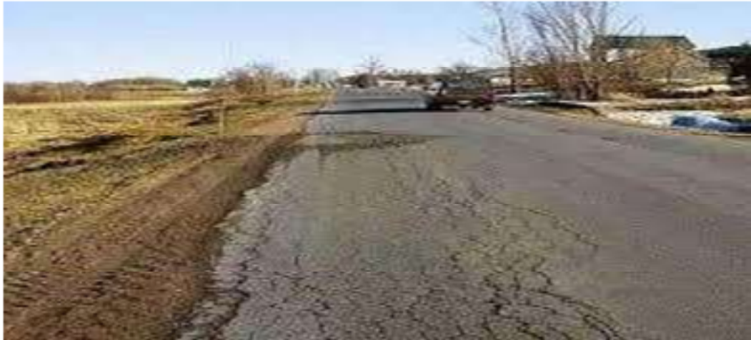
Gambar 2.5 Cacat Tepi Perkerasan (Sumber: Google 2023)
