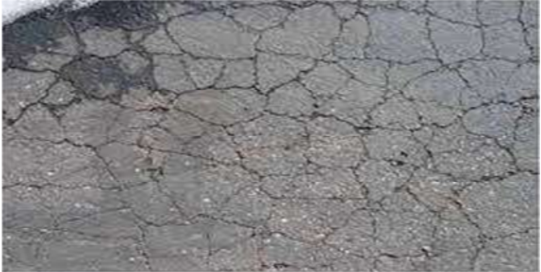
Gambar 2.2 Retak Kulit Buaya.
