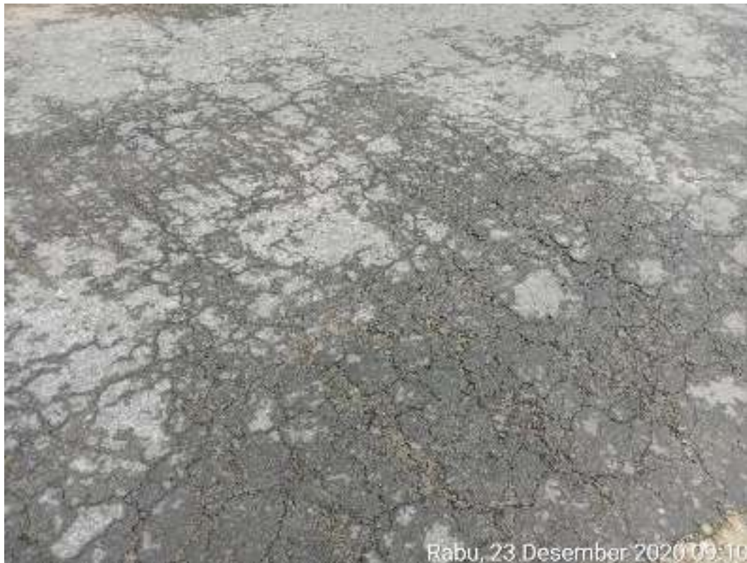
Gambar 3.1 Retak kulit buaya
